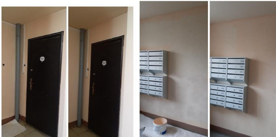
Малярные работы на 1х этажах.
